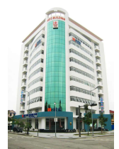
Cty CP Xây lắp TT Huế
